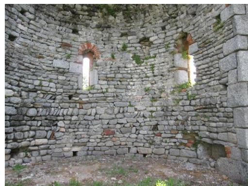
semicircolare sotto cui è posto un architrave dalla caratteristica forma trapezoidale. Altre due porte minori si aprivano sulle fiancate dell'edificio. Delle finestrelle a doppia strombatura si aprono ancora oggi invece nell'abside maggiore, una sola nelle absidi minori. La muratura dell'edificio è costituita da pietra squadrata in serizzo che ricopre ciottoli e materiale di reimpiego, tra cui frammenti di sesquipedali e di tegoloni.
