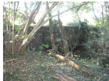
Diga rivo Vallalta
